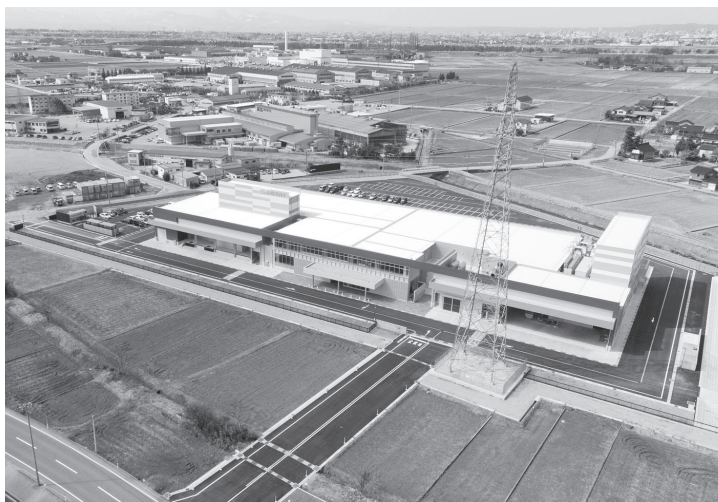
富山スガキ株式会社 立山工場全景
