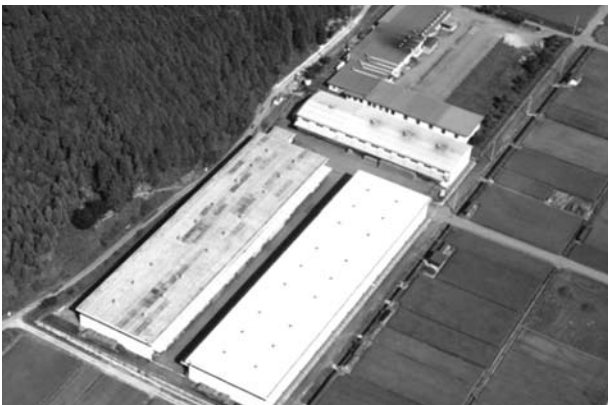
岡前倉庫全景
