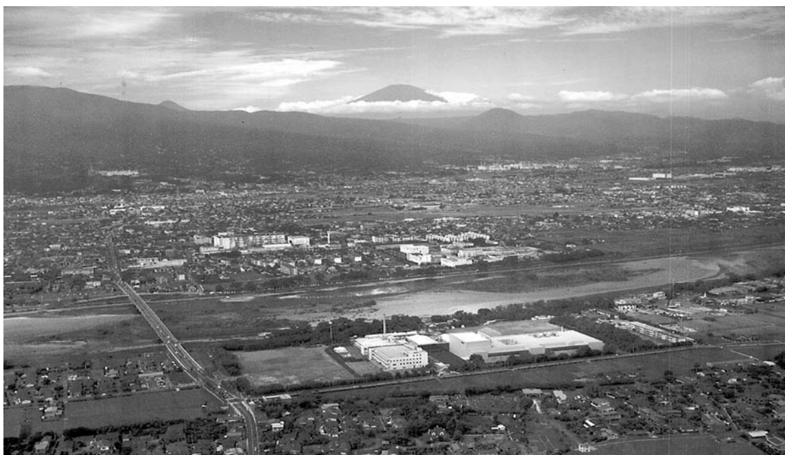
写真1 小田原総合製剤工場全景
